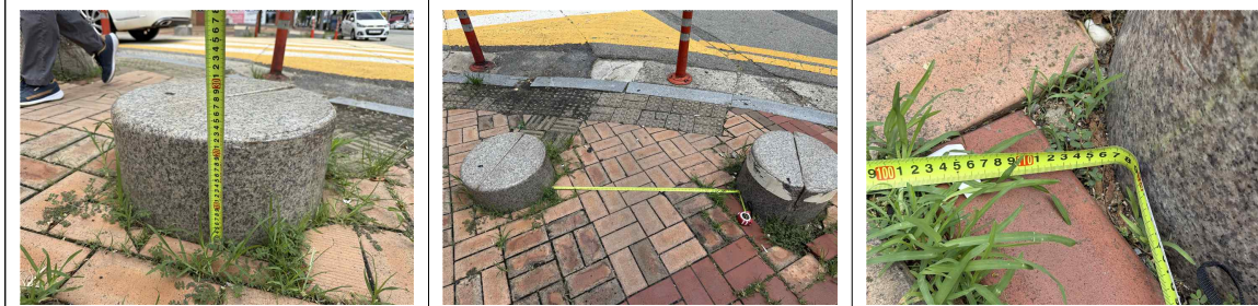
20~30cm 높이의 석재 원형볼라드, 볼라드 사이 간격 115cm~ 최소 유효폭 기준 미달
