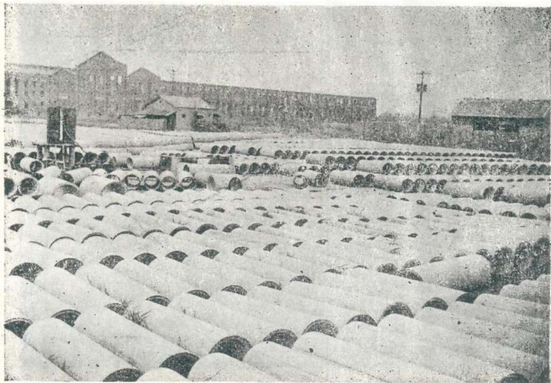
上水道工事に所要할 壓管光景
